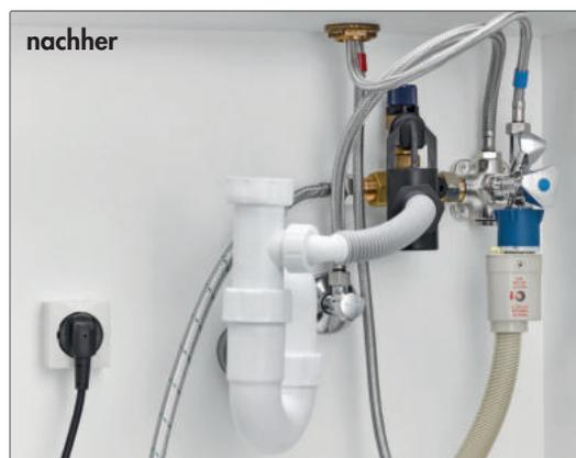
Der Anschluss der Water Box an ein bauseitiges Eckventil darf im Rahmen der Tätigkeiten der "Möbel-fachkraft für festgelegte Tätigkeiten" Modul 2 Sanitärtechnik (Modulreihe TÜV Rheinland Akademie [www.tuv.com](http://www.tuv.com)) in Zusammenhang mit einer Küchen- oder Möbelmontage erfolgen.
