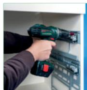
2. GRASS-Führung in Montageplatte einlegen, auf vorhandene Cox® Base Kunststoffschiene aufsetzen und korpusbündig montieren ("quick & easy").
