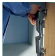
2. Drehgestänge komplettieren und einsetzen.
