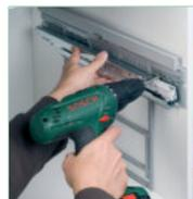
1. GRASS-Führung 470 mm in Seitenteil einlegen und korpusbündig montieren (quick & easy).
