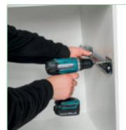
2. Auszugsschienen und Aufnahmebolzen für Ablagedeckel montieren.
