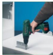
4. Frontbefestigung mit Schablone montieren.
