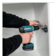
2. Auszugsschienen und Aufnahmebolzen für Ablagedeckel montieren.
