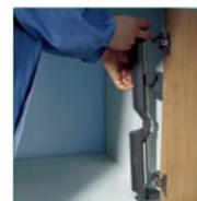
2. Drehgestänge komplettieren und einsetzen.
