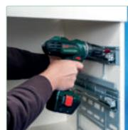
2. GRASS-Führung in Montageplatte einlegen, auf vorhandene Cox® Base Kunststoffschiene aufsetzen und korpusbündig montieren ("quick & easy").
