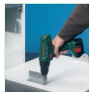
4. Frontbefestigung mit Schablone montieren.
