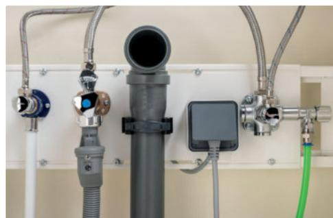
Monté de façon propre et bien ordonnée: eau froide et eau chaude, écoulement de l'évier, prise en saillie, raccordement des conduites d'eau potable (par exemple pour une machine à café avec un raccordement fixe pour l'eau ou un réfrigérateur avec un distributeur de glaçons).
